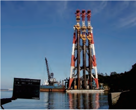
海上SCP施工状況
