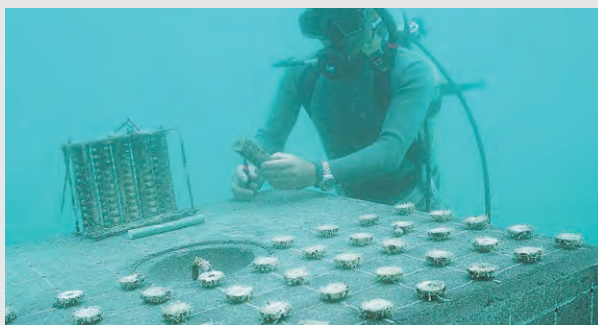
マリブロック®へのサンゴ着床具設置状況
