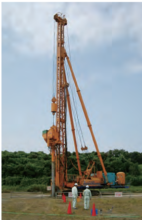
陸上SCP施工状況
