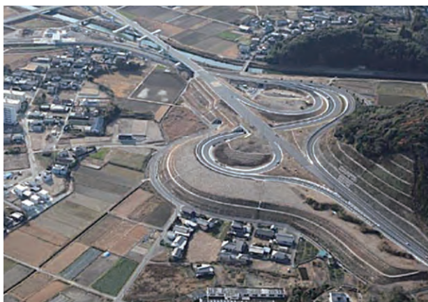
東九州自動車道（NEXCO 西日本提供）
