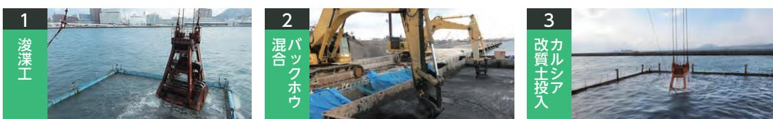
① グラブ浚渫船で水深10mまで浚渫 ② 浚渫土砂をカルシア改質材との混合場所まで運び、解泥後に改質材と混合。5つの工事のうち最初の工事で約1ヵ月間、混合の試験施工を実施し、改質材を全量投入から段階的に投入・混合する方式に改め、混合時間を約60分に短縮。施工効率を上げた ③ 改質土投入箇所の周りは汚濁防止フェンスで囲う
