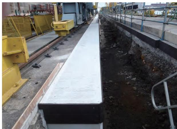
塩害による鉄筋の腐食に対する寿命が1.5倍となることから、岸壁上に構築するコンクリート構造物に適用された
