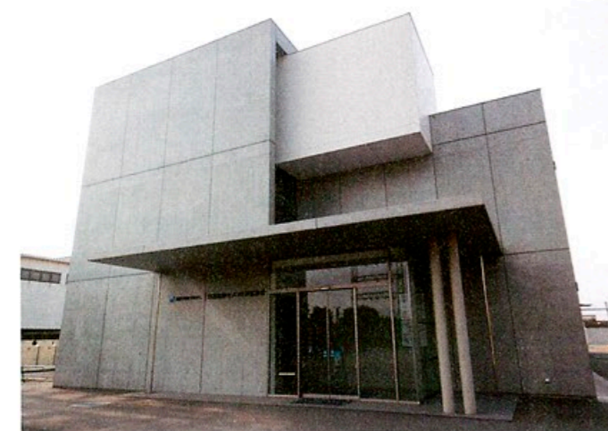
外観はRC造らしい打ち放しの仕上げとし、素材の力強さを感じさせるデザインに(写真左)。室内でポイントとなったのは、2階の執務室だ。約18mものスパンで構成される大空間では、上階の床を支えている梁をそのまま打ち放しで表すことによって、室内側にもコンクリートらしい質感が伝わってくる(写真下) (写真提供/日鉄高炉セメント)
