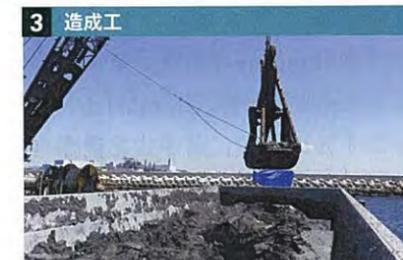
① クレーン付き台船で浚渫。土運船に1回当たり300m<sup>3</sup>積み込む ② 浚渫土をバックホウで30分間解泥。カルシア改質材を加えて90分間混合し約430m<sup>3</sup>のカルシア改質土に ③ 投入用クレーン付き台船を横付けしカルシア改質土を所定の海域に投入
