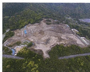
この太陽光発電所造成工事は、開発区域約43ha、造成土量約100万㎡に及ぶ大規模なもの。3つの調整池を整備したうえで、区域全体を8つの工区に分け、工区ごとに「カタマ®SP」を用いた簡易舗装工事を施した
