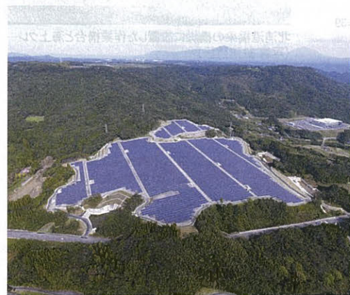
この太陽光発電所造成工事は、開発区域約43ha、造成土量約100万㎡に及ぶ大規模なもの。3つの調整池を整備したうえで、区域全体を8つの工区に分け、工区ごとに「カタマ®SP」を用いた簡易舗装工事を施した
