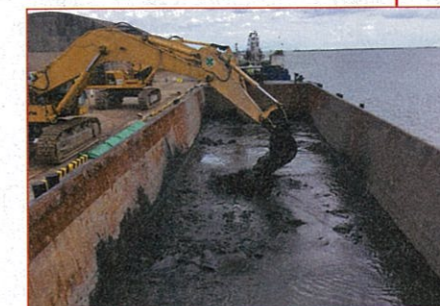
土運船で運んだ浚渫土を3.1m 3 クラスのバックホウで片側から30分攪拌した後、土運船の向きを変え、反対側からさらに30分攪拌。カルシア改質材と混合しやすいため解泥し密度を均一にする
