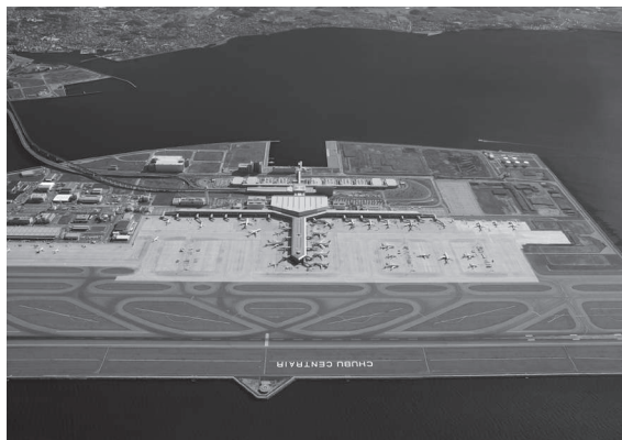
中部国際空港セントレア用地造成工事(2001)・2004年では、滑走路・誘導路の路盤、エラロン(駐機場の路床材などに、約190万トンの鉄鋼スラグ製品が使用された。
