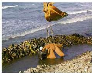
2004年の秋、実験区の海岸線30mに穴を掘り、06のビバリー・ユニットを埋設
