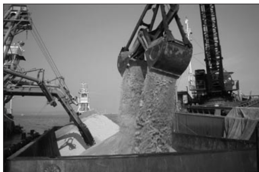
ガット船から土運船へ積み替え
