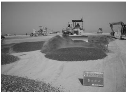
ブルドーザーによる敷き均し
