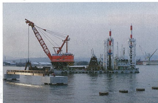
大型クルーズ船を受け入れられるように、浚渫エリア内は水深10mまで浚渫する。グラブ容量25m 3 級の浚渫船を用いる
