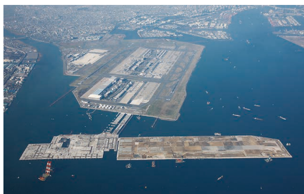
東京国際空港 D 滑走路建設外工事
