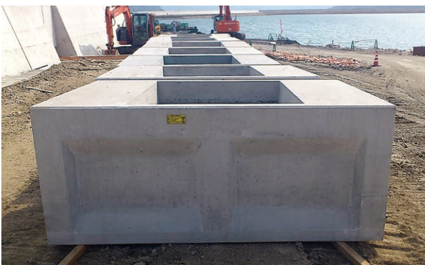
広島港護岸工事のプレキャストブロック（高炉スラグ細骨材）
