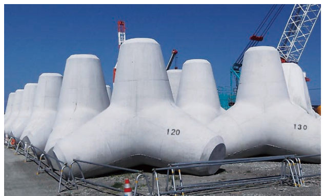
消波ブロック（電気炉酸化スラグ骨材）
