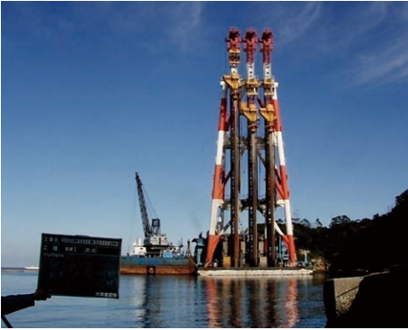
海上SCP施工状況
