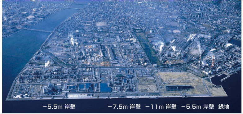
大竹港東栄地区岸壁全景（広島湾再生プロジェクトHP）
