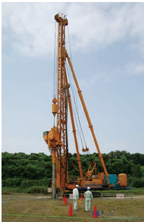
陸上SCP施工状況
