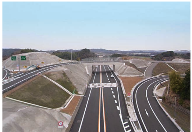
東九州自動車道（NEXCO 西日本提供）
