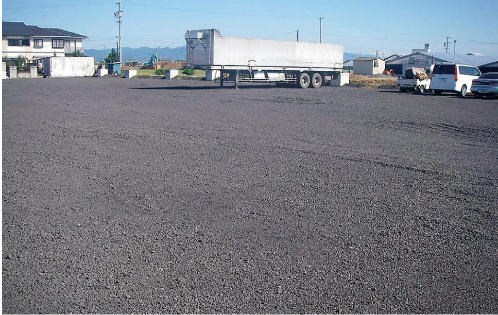
施工例（駐車場整地：愛知県豊橋市）
